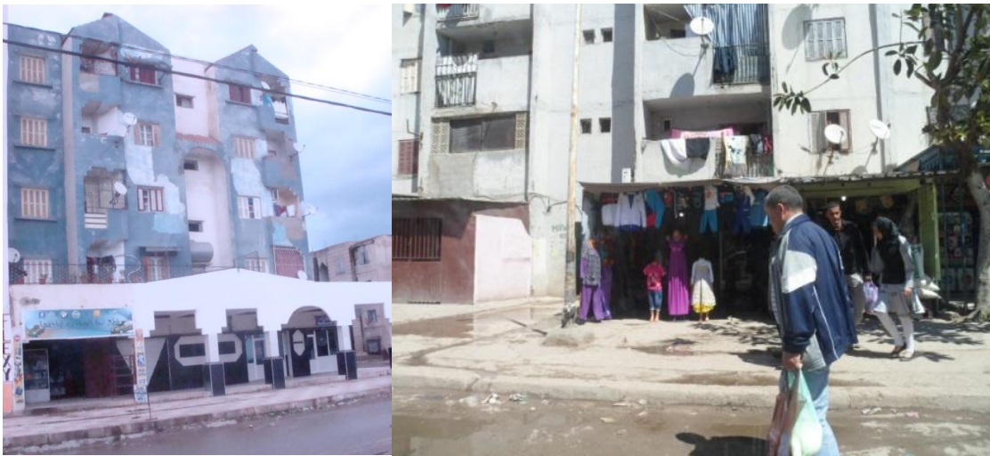
Photo 73, 74: Les commerces de proximités intégrés au RDC des immeubles d'habitation. Source auteur.
