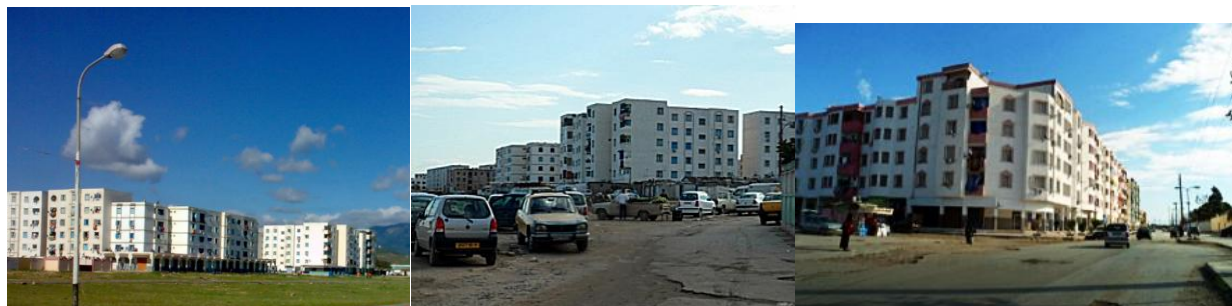
Photo n° 29 : Programme 114 logements Photo n° 30, 31 : Les deux programmes 280 logements. Source auteur prise en novembre 2014.
