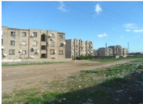
Photo n° 26 : La façade postérieure des 700 logements. Source auteur.
