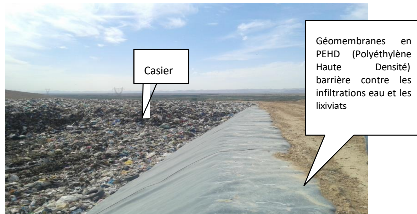
Figure 32 : Remplissage d'un casier CET Biskra
