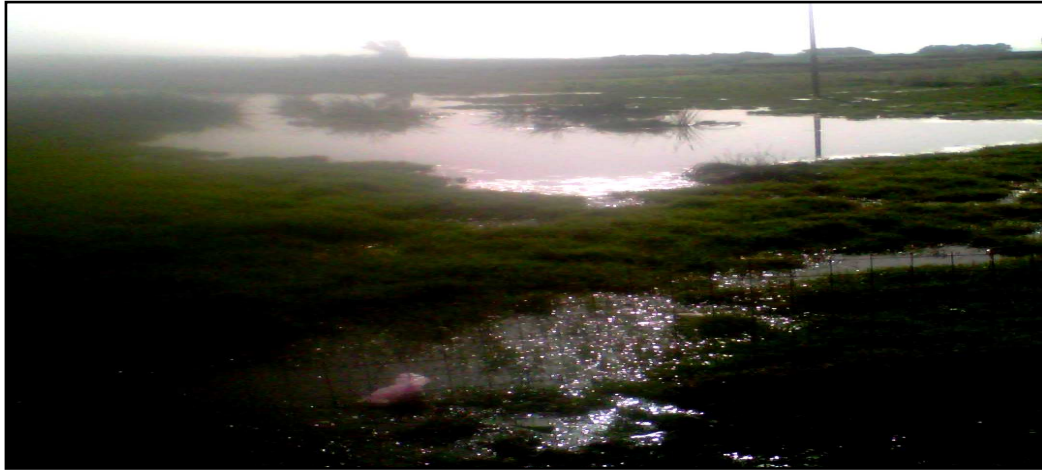
Fig.48. Les rejets des eaux usées de la région de Zaouia à ciel ouvert
