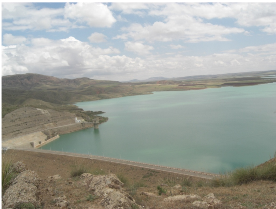
Figure 62 : Photographie montrant la digue du barrage de Foug el Khanga sur l'Oued Cherf.
