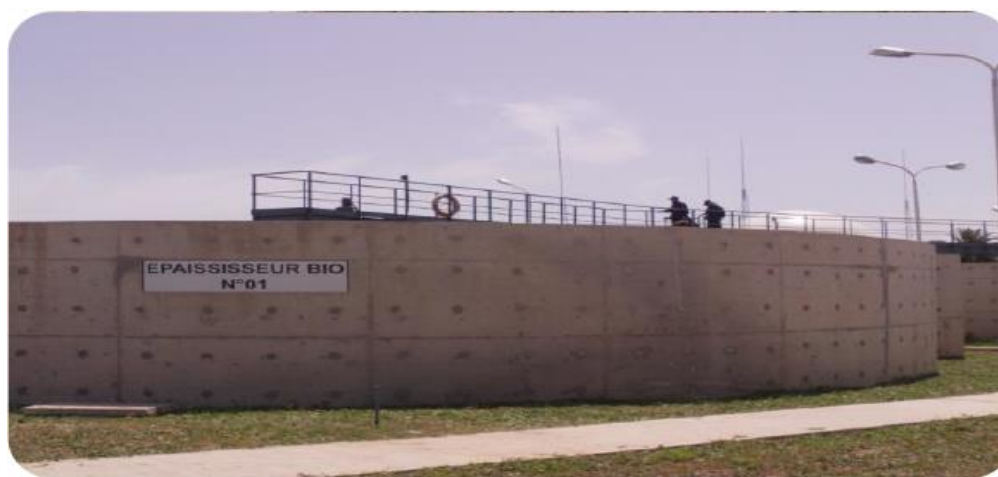
Figure n°21. Bassin d'Epaisseur des Boues Biologiques (Station d'El-Allélick, Annaba).
