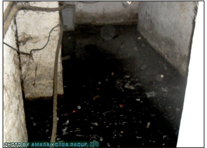
Gîte Hypogé Urbain -Cave d'un Bâtiment- El-Kala
