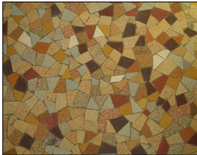
Fig. 1.20. Placage en grés de céramique. Source : rome-rome.net
