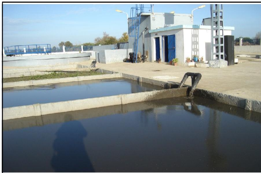
Figure13 : Station d'épuration de zrizer
