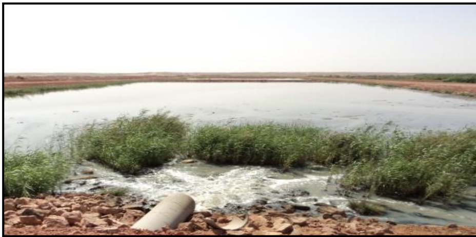
Figure 9: Bassin de décantation
