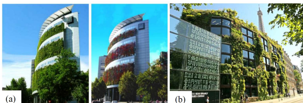
Figure 57 Le mur végétal
