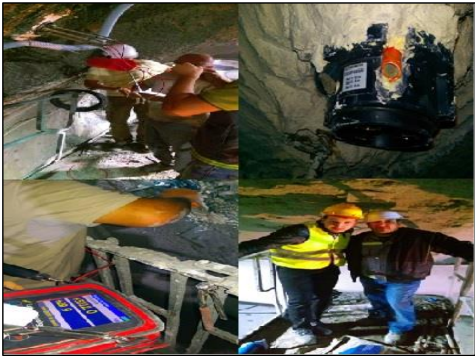
Figure IV.6 : installation de l’extensomètre
