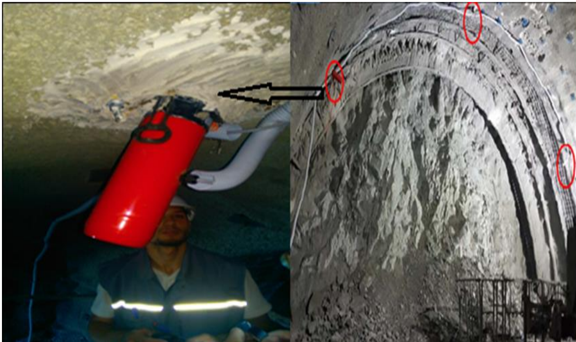
Figure IV.6 : installation de l'extensomètre
