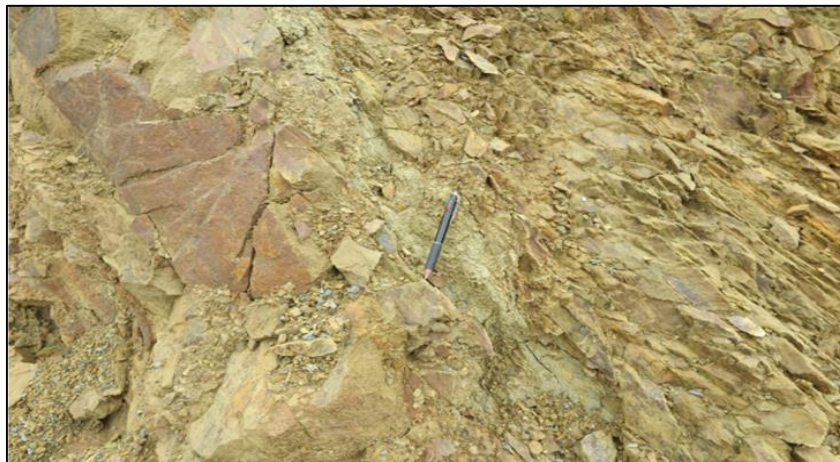
Figure II.14 : Unités de rocher qui seront passées par le tunnel aux environs de PK 37+000 et vue en surface des systèmes de discontinuité (zone de faille) qu'elle possède, vue vers le nord-ouest.
