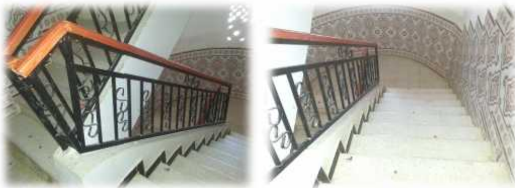
Figure 42: la cage d'escalier du 2 ème cas d'étude.
