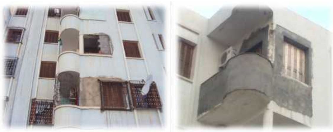
Figure 61: Des modifications au niveau des façades.
