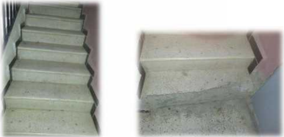
Figure 58: la cage d'escalier du 3eme cas d'étude.
