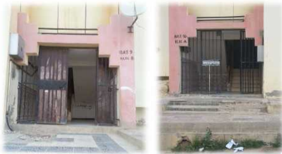
Figure 41: l'entrée de bâtiment du 2 ème cas d'étude.
