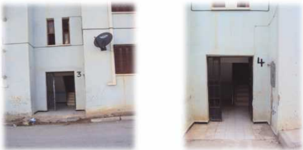
Figure 60: le seuil du bâtiment du 3 eme cas d'étude.
