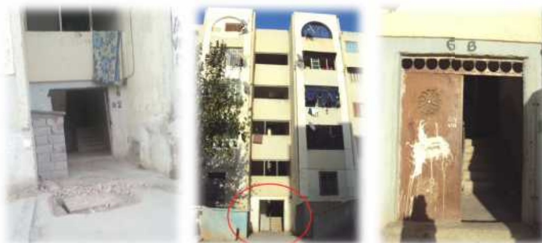
Figure 25: L'entrée des bâtiments.
