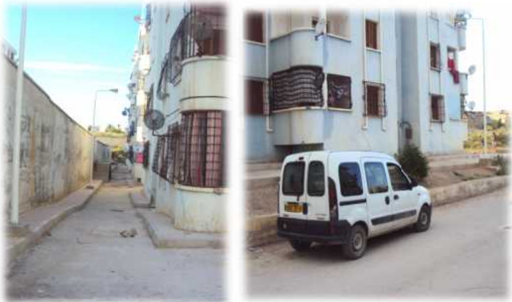
Figure 59: l'espace devant l'entrée du bâtiment.
