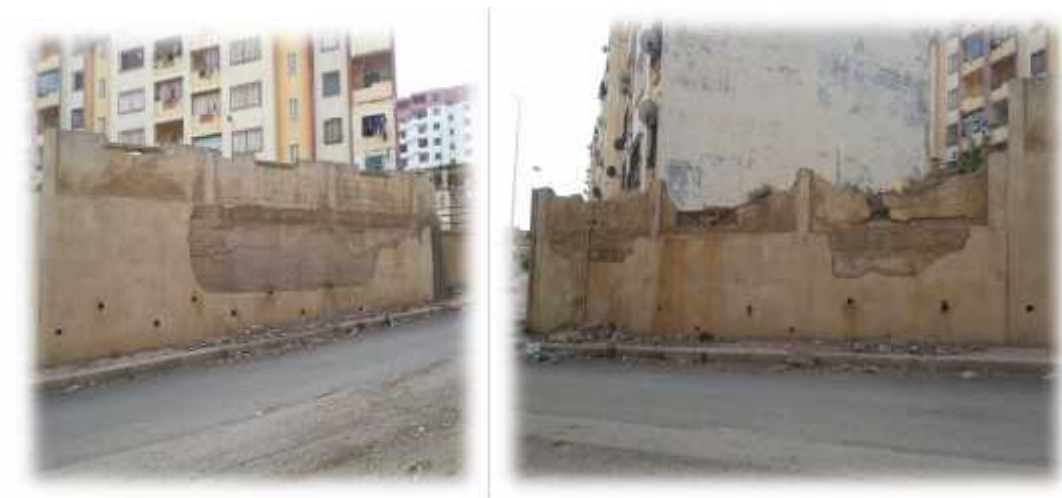
Figure 39: L'état physique du cadre bâti au niveau du quartier 2 ème cas d'étude.
