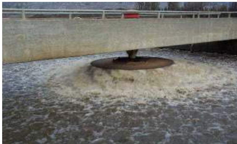
Figure II-3 : Turbine de surface à vitesse lente
