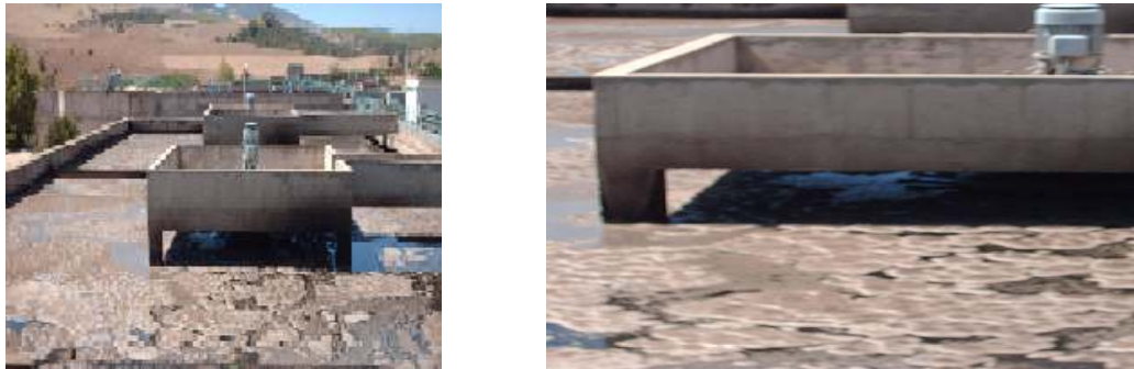
Figure V-13 : Couche de la mousse biologique en surface de bassin d'aération de la STEP de Souk-Ahras
