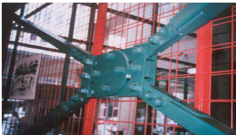
Figure 7.20 Amortisseurs à frottement [17]
