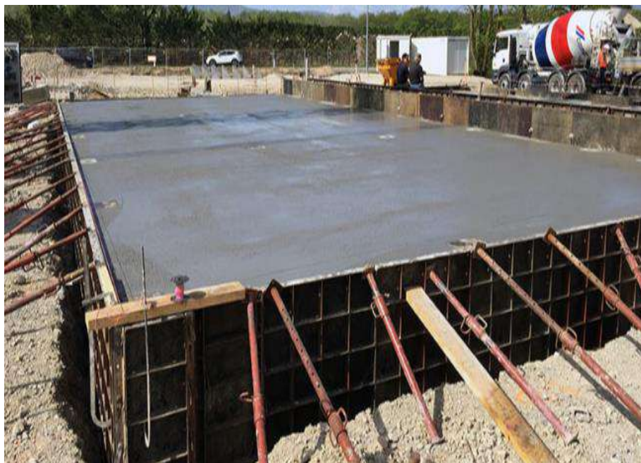
Figure 7.3 Radier en béton armé [26]
