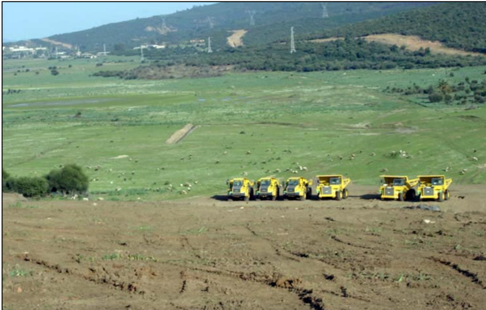
Photo 6 – Travaux de construction de l'autoroute est-ouest, novembre 2008 Cliché Hamouda
