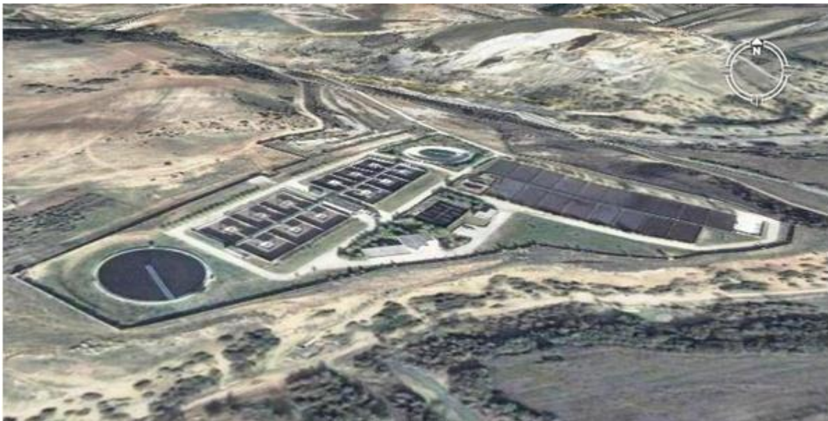
FigureN°11 : Image satellite de la station de traitement des eaux polluées de Souk-Ahras
