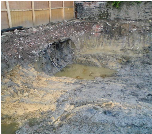
Figure N°02 : Décaissement d'un sol pollué par un réservoir de goudron.
