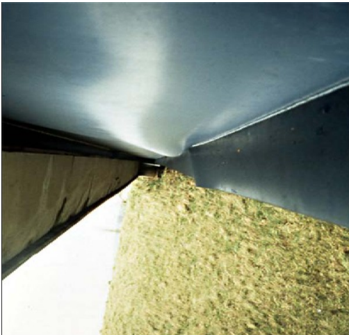
Fig.1.6.b Voilement de l'âme
