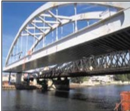
Fig.2.6 Exemples d'utilisation des PRS dans les Ponts
