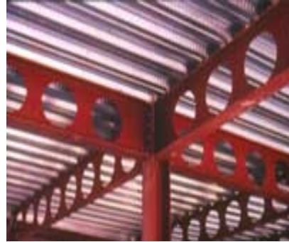
Fig.2.10 Poutre alvéolaire cellulaire
