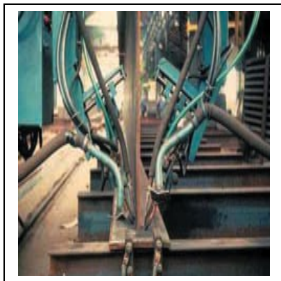
Fig.2.2.a Soudage semi-automatique sous flux solide
