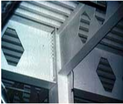
Fig.2.9 Poutre alvéolaire hexagonale
