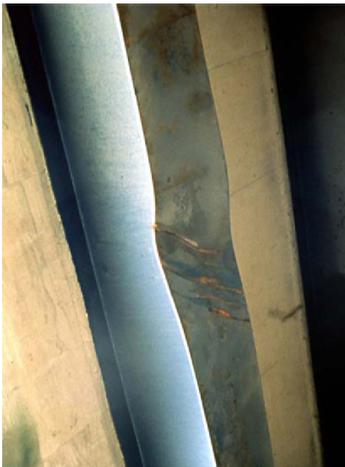
Fig.1.6.b Voilement de l'âme
