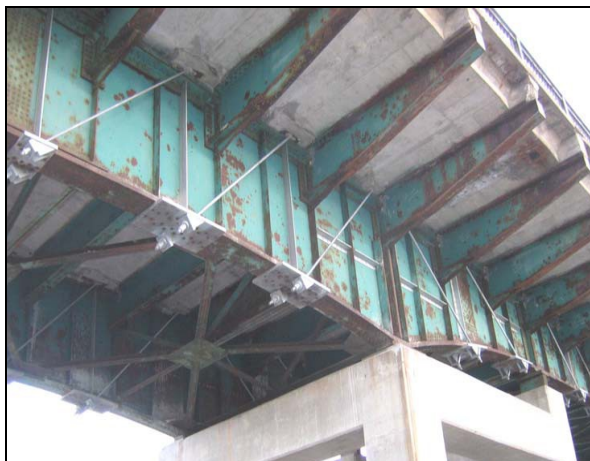
Fig. 1.18 Aspect final des renforts
