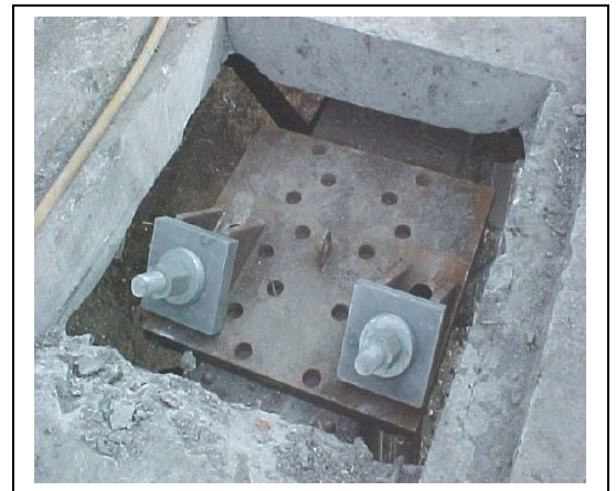
Fig. 1.17 Pose des renforcements en chantier
