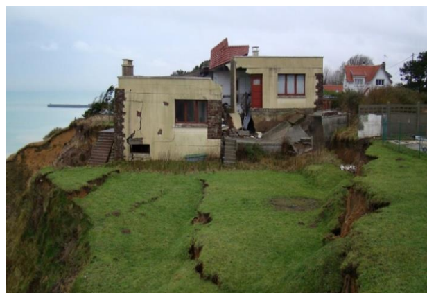
Photo 3. Glissement de terrain lié à un éboulement de falaise en pied (Dieppe, 2012). © BRGM - P. Pannet
