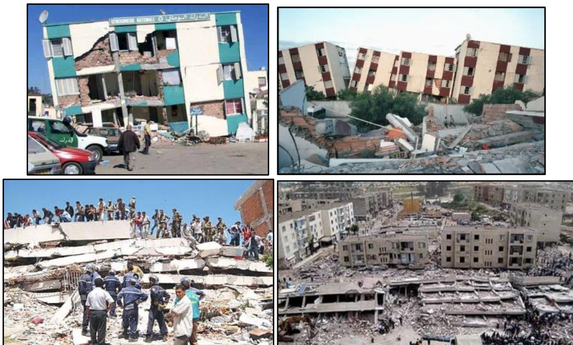
Photo 1. Photos a, b, c et d. Séisme de Boumerdes -Zémmouri, Algérie Mai 2003. Source : https://www.gettyimages.fr/photos/tremblement-de-terre-en-algerie
