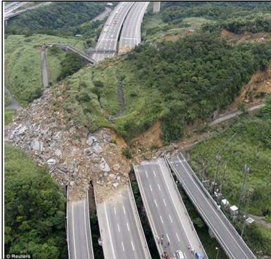
Photo 6. Impressionnant glissement de terrain à Taiwan ! Autoroute n°3 entre Keelung et Taipei en Taiwan, le 26 Avril 2010 !source. journal Taiwan info.
