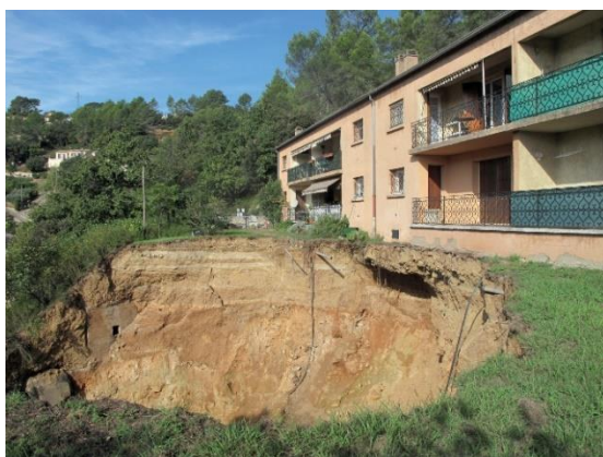
Photo 2. Effondrement provoqué par la présence de gypse (Le Luc, Var). © BRGM
