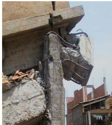
(4) Formation de rotule plastique au niveau d'un poteau Alger Séisme du 21 mai 2003
