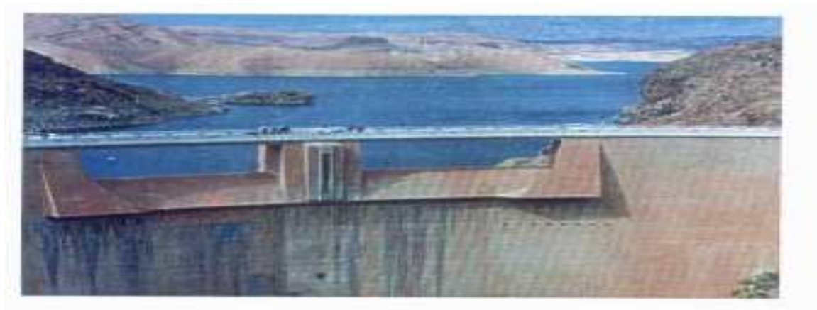
Fig. 64. Barrage de Foug El Gharza
