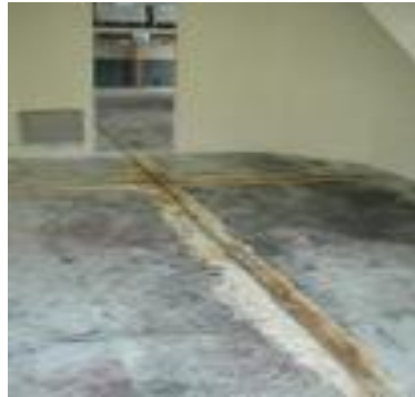
Figure 1.22. Exemple de réparation par l'injection de résine époxydes [104].
