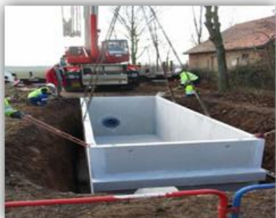
Chambre à vannes – Chantier de Strasbourg
