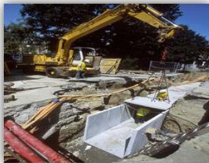
Galerie multi-réseaux – Chantier de Mulhouse
