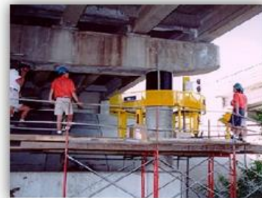
Enveloppement de colonne (l'enroulement filamentaire)
