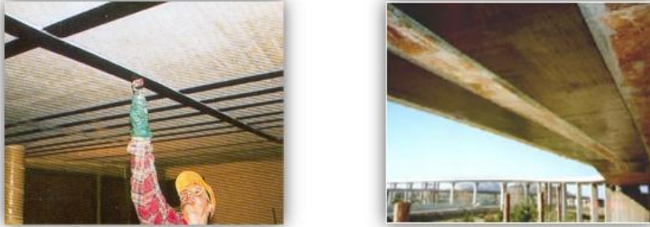
Figure 1.7. Exemple de renforcement des dalles par le béton de résine.
