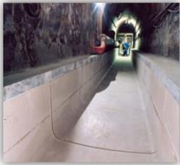
Cunettes Avenue Jean Jaurès – Chantier de Paris
