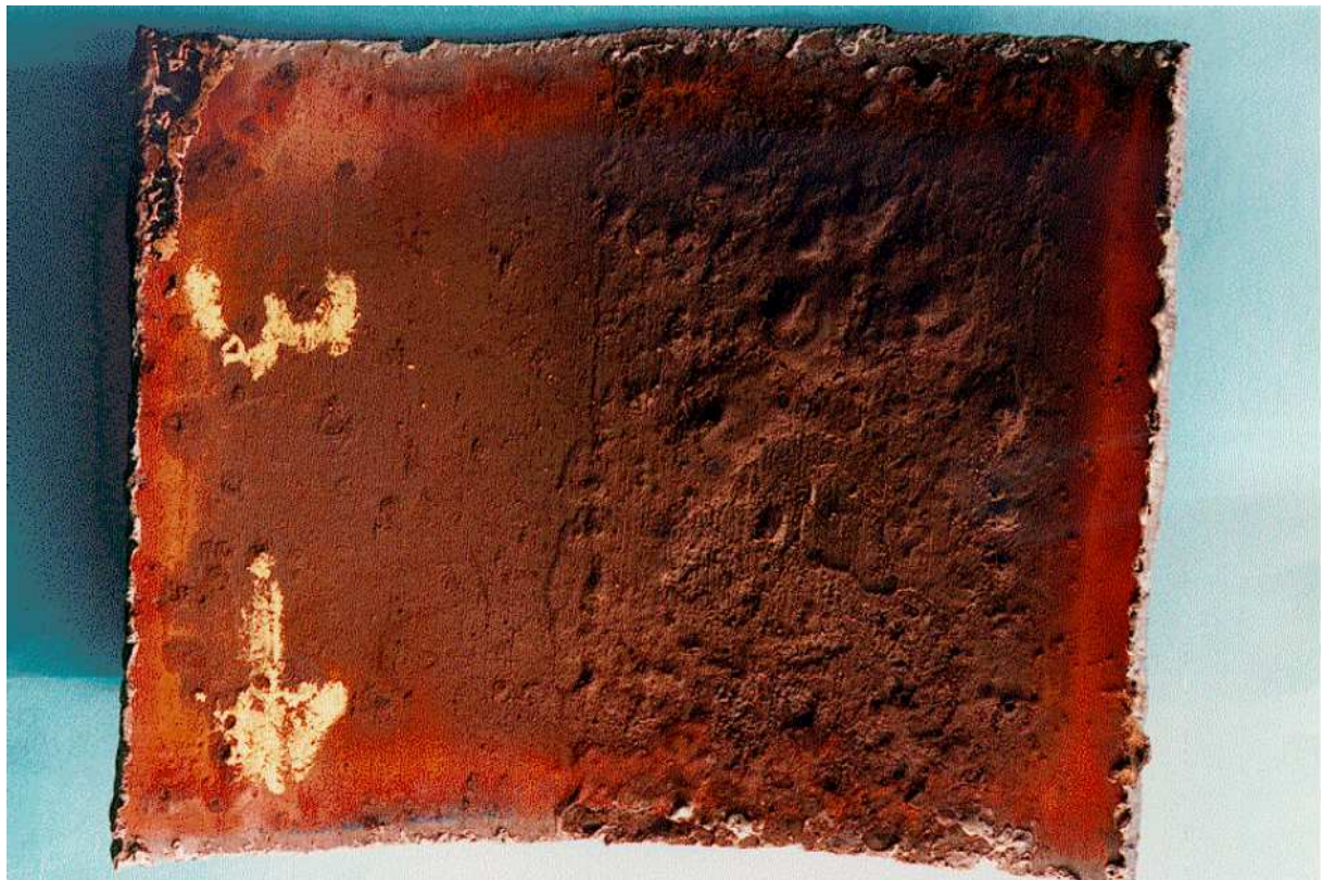
Fig.2.2. Pertes de métal dues à la corrosion interne [53].
