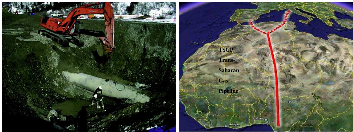
Fig.1. 1. Excavation de pipeline pour examiner le revêtement extérieur et évaluer la corrosion [27].
