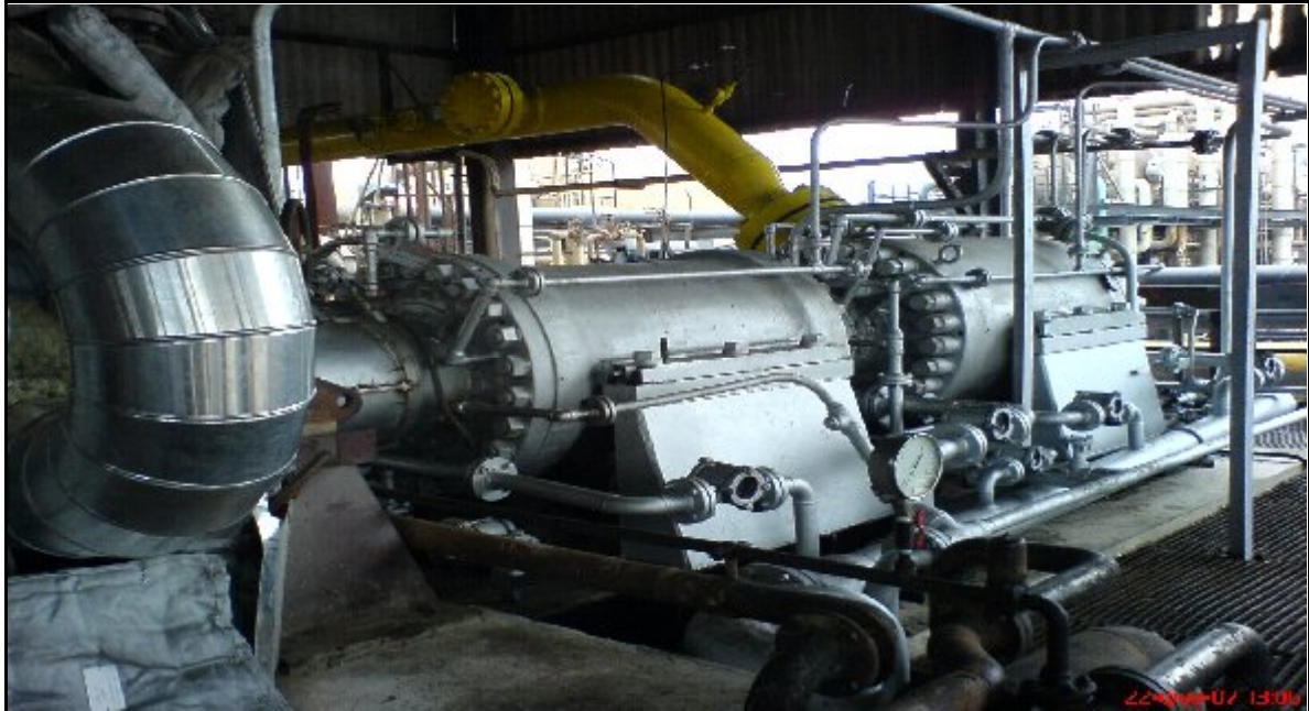
Figure (IV -1) : Photographie de la Turbine à vapeur [21]
