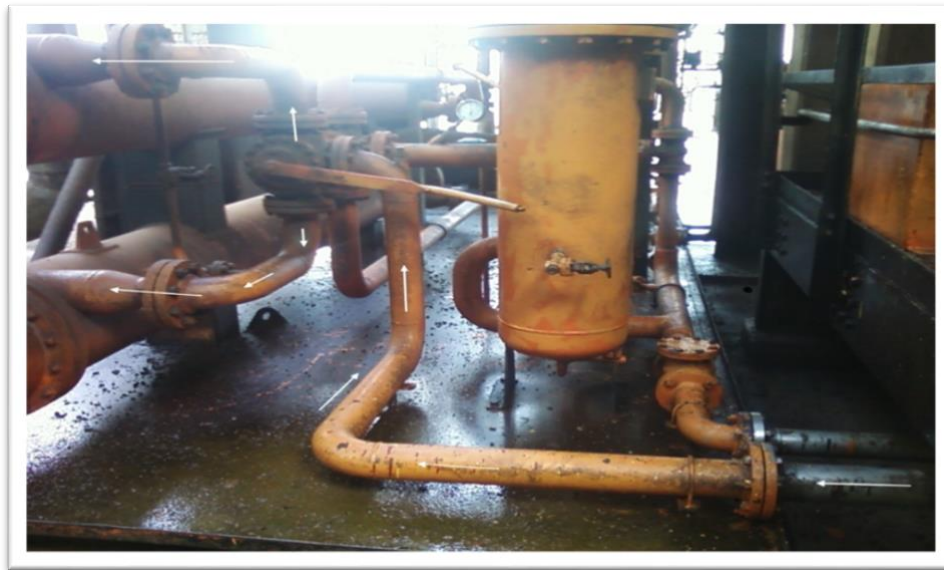
Figure 18: Réfrigérants d'huile de graissage [10]
