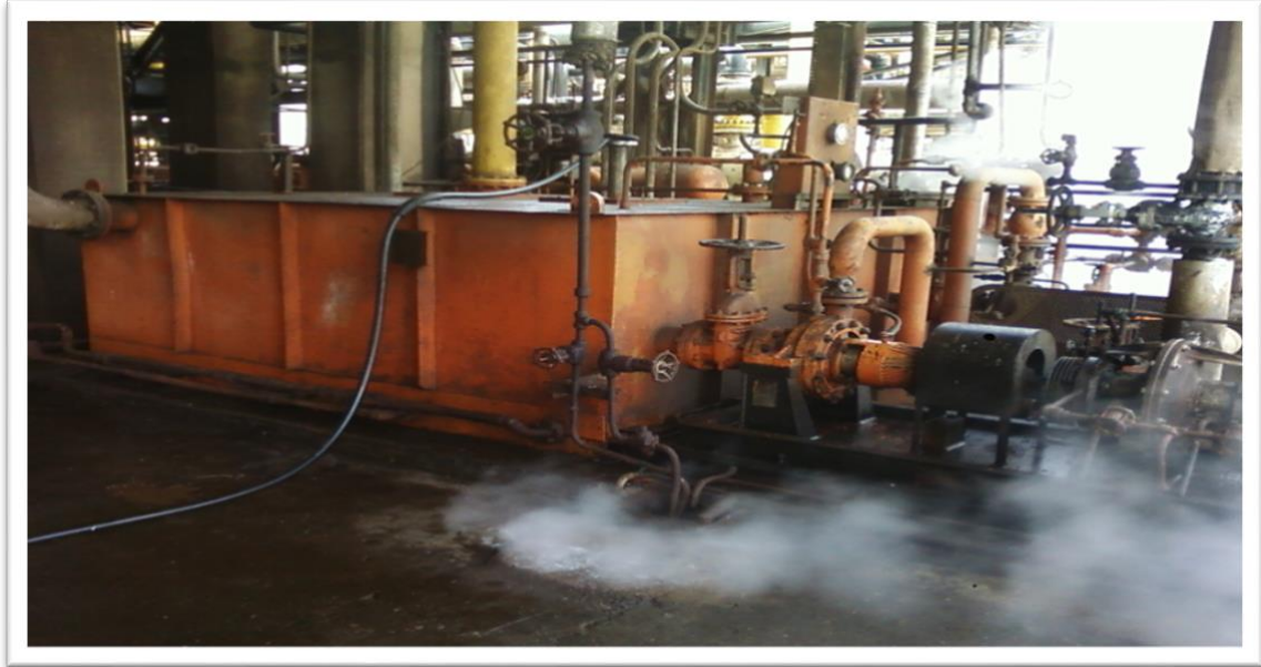
Figure 15: Réservoir d'huile de graissage. [10]
